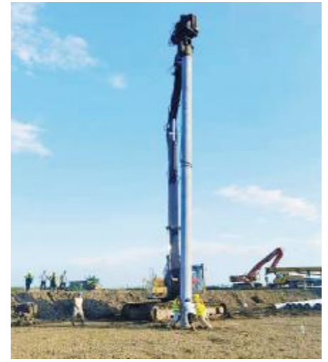
台山项目布下第一根桩
